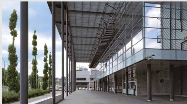
Messe Zürich direkt neben dem Hallenstadion
