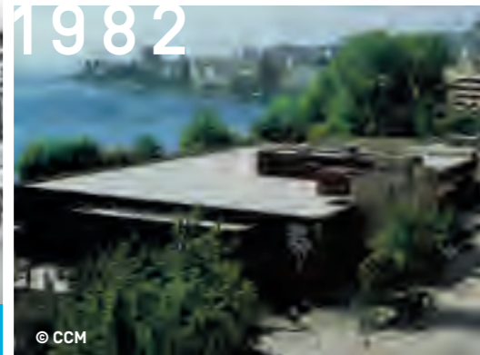
1982 © CCM Extension et naissance du bâtiment B
